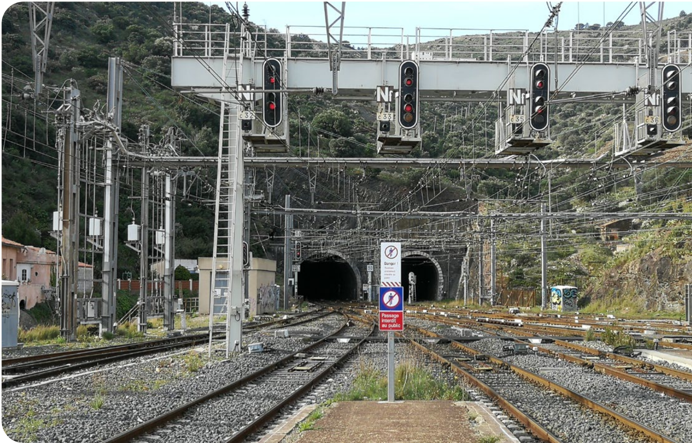
↑ Tunnels entre la gare de Cerbère et Portbou, 2021 - © Anafé
